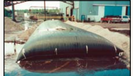
Entwässerung von Kohleschlamm mittels TenCate Geotube® Entwässerungstechnologie
