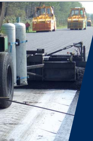
Sanierung bestehender Asphalt-schichten mit Ausgleichsschicht
